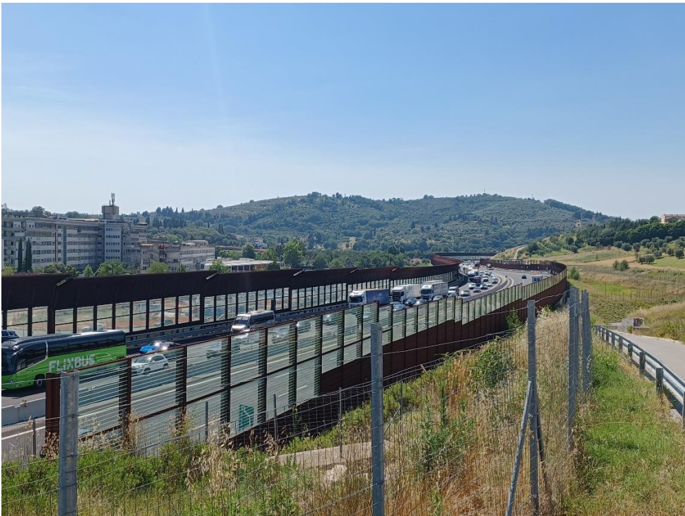
Figura 3. Osma - Barriere acustiche.
